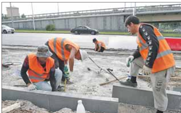
На проспекте Мира укладывают новый бордюрный камень и плитку
